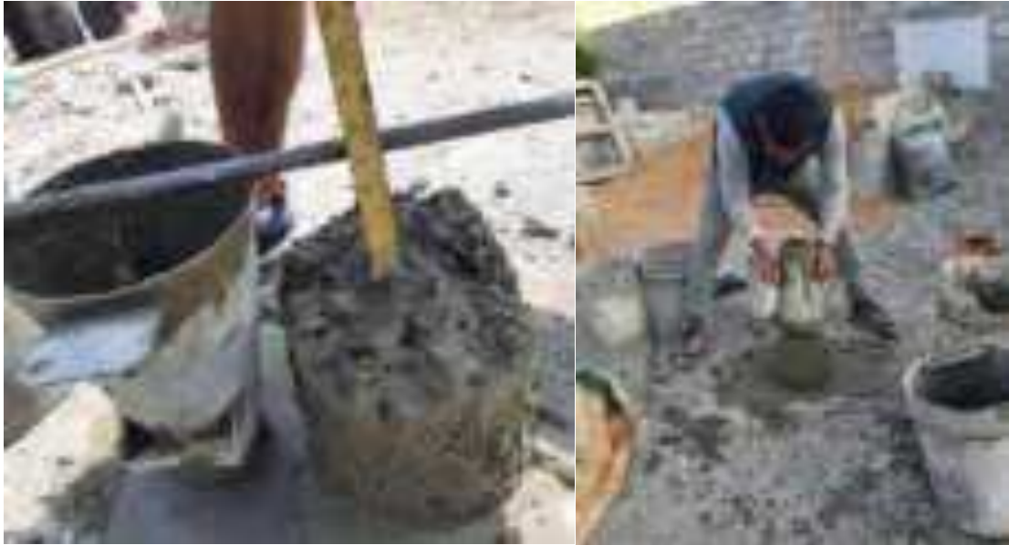
Fig. 28. Medición de asentamiento del concreto.
