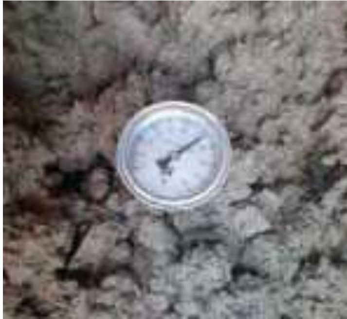
Fig. 29. Medición de lectura de temperatura del concreto.
