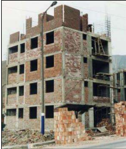
Fig. 4. Albañilería confinada [47]
