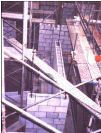
Fig. 3. Albañilería armada [46]
