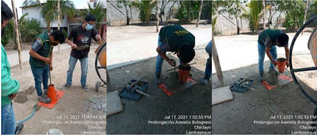
Fig. 6. Ensayo de Slump
