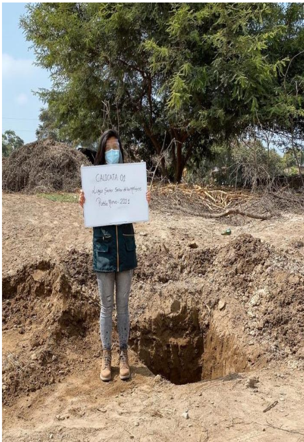
Fig. 2. Excavación de la C-01
