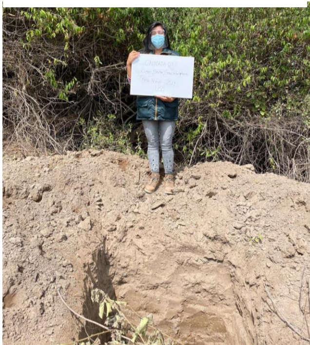
Anexo: Excavación de calicata 03
