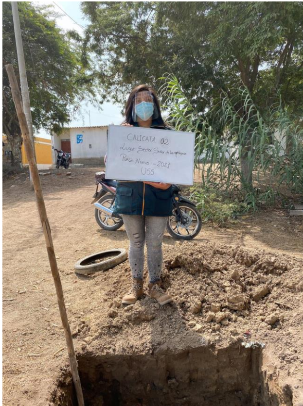
Anexo: Excavación de Calicata 02
