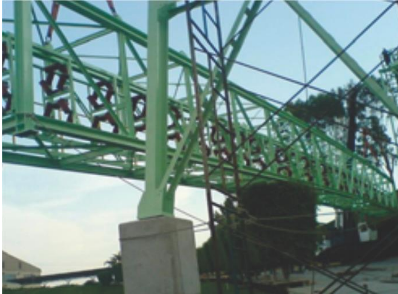
Figura 3. Proyectos ejecutados por la empresa (montaje de estructuras metálicas)
