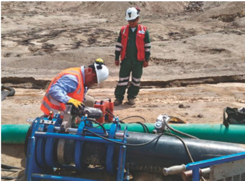
Figura 4. Proyectos ejecutados por la empresa (trabajos de electro fusión y termofusión)
