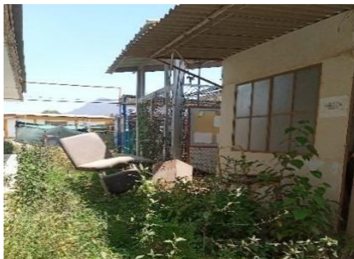
Figura n° 12. Estado actual del C.S Olmos. Fuente: Elaboración Propia.
