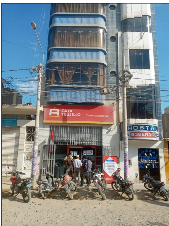
Caja Municipal de Ahorro y Crédito de Trujillo – Agencia Moshoqueque
