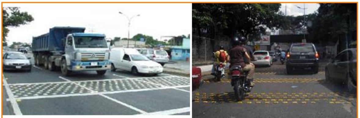
**b. Líneas reductoras de velocidad:** Busca generar una ilusión óptica al chofer, con el fin de disminuir la velocidad, suelen usarse en los
