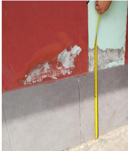
*Figura N° 4. Registro de la patología en muro exterior y columna*
