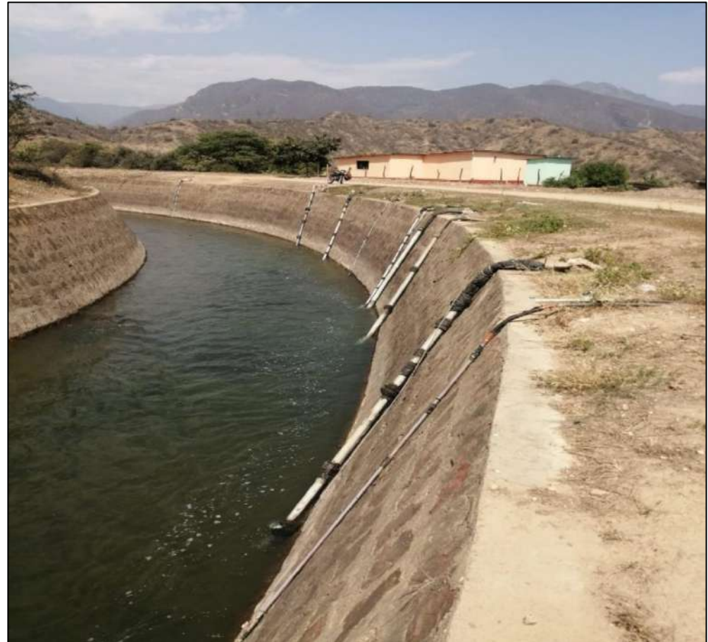
Tuberías de PVC y motobombas, instaladas por pobladores formales e informales en todo el trayecto del canal alimentador del Sistema Tinajones, las cuales extraen en diferentes volúmenes el caudal transportado por el canal Alimentador
