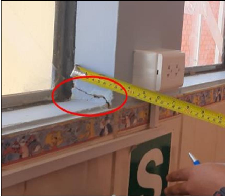
**Figura 20.** *Grieta entre columna y ventana.*
