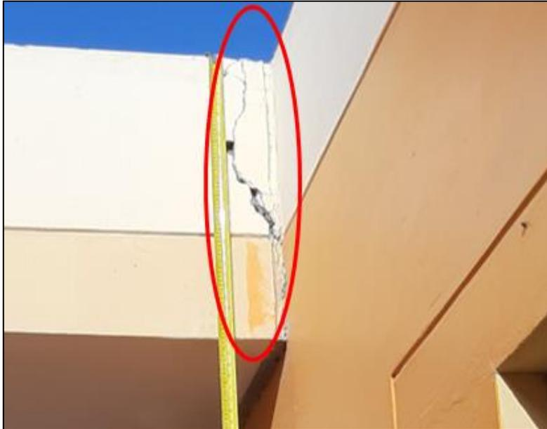
**Figura 21.** Grieta debido a deficiencia en el método de unión.
