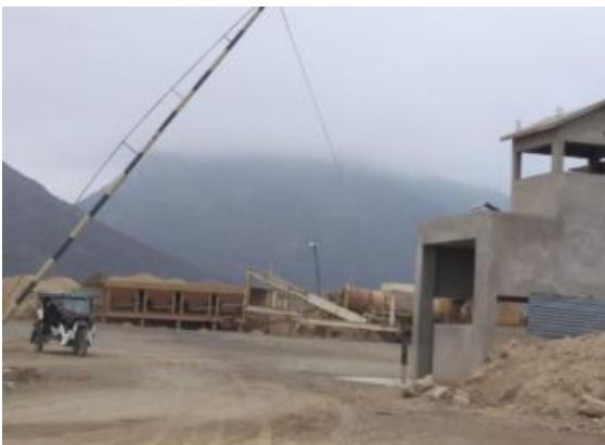
Planta de asfalto y cemento asfáltico
