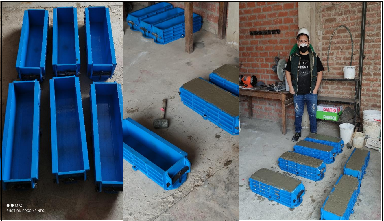
Figura 37 Vaciado de concreto en Moldes de Vigas
