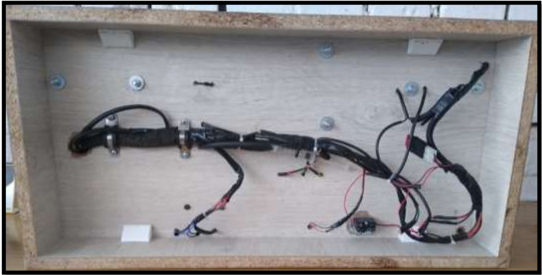
Figura 56. Ramal eléctrico instalado en el interior del módulo.
